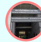
วิทยาลัยปิโตรเลียมและปิโตรเคมี และสถาบันวิจัยโลหะและวัสดุ อาคารวิทยาลัยปิโตรเลียมและปิโตรเคมี
